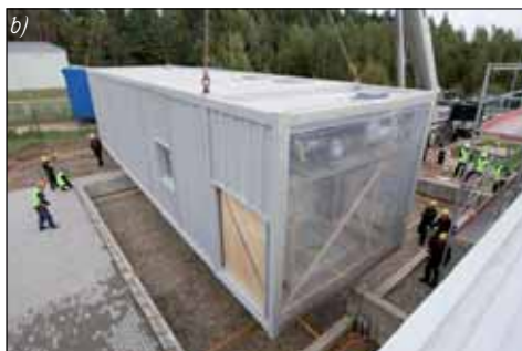
Obr. 3.12 - skládání kontinuální centrifugy(a); skládání kontejnerového systému stavby čistých prostor(b) - Sicor Biotech, Litva
