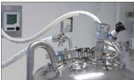
Obr. 3.10. - flexibilní hadicová propojení procesní nádoby v biotechnologickém provozu (Sicor Biotech, Litva)
